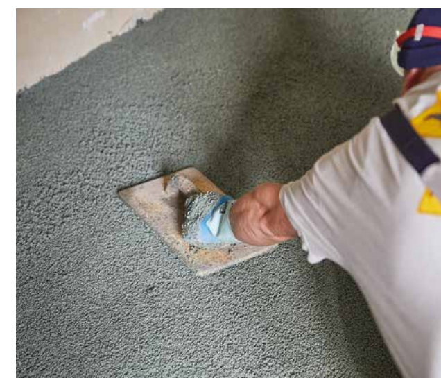
Der zementgebundene Knauf S 400 Sprint beim Einbau.
