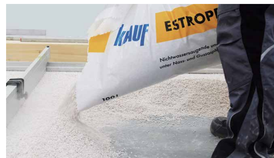
Knauf Estroperl ist besonders leicht und wasserabstoßend.
