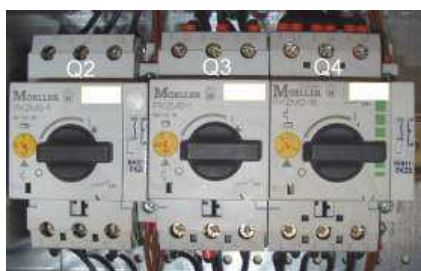
Fig. 1 Interruptor de protección del motor
