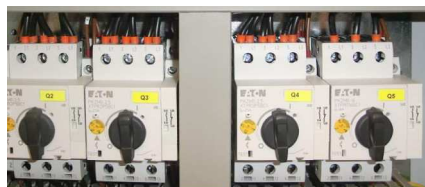
Fig. 1: Interruptor de protección del motor
