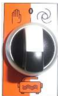
Figure 19 : Sélecteur de la pompe d'augmentation de pression
