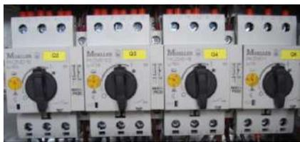
Abb. 5: Motorschutzschalter
