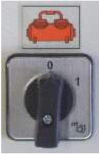
Abb. 20: Wahlschalter Luftkompressor
