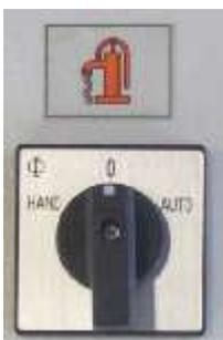
Abb. 19: Wahlschalter Druckerhöhungspumpe
