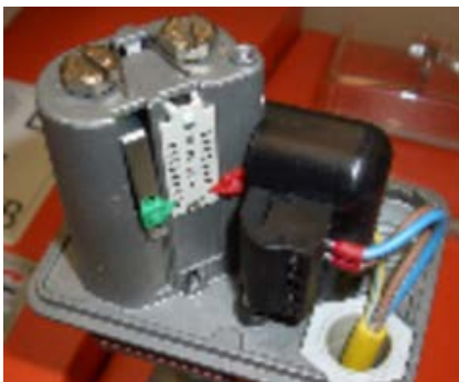
Abb. 65: Druckschalter
