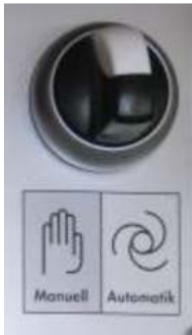
Abb. 12: Wahlschalter Rotationskompressor
