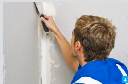
Press in (bed) Knauf Kurt joint tape
