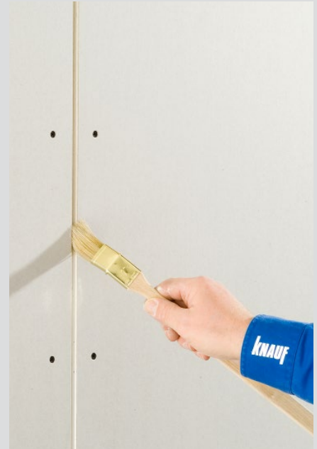
Application of Knauf Tiefengrund on bevelled cut edges
