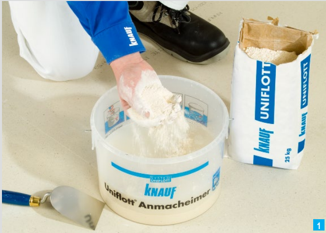
Sprinkling of Knauf Uniflott
